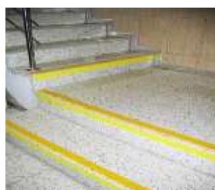
Технические средства, используемые на путях (путях) движения внутри здания (в т.ч. путях эвакуации).<sup>48</sup>
