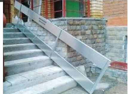
□ **Перила** Безопасность при спуске и подъёме по пандусу обеспечивают специальные перила с двумя поручнями (перила для инвалидов), которые служат при передвижении дополнительной опорой. Чаще всего используются перила, выполненные из нержавеющей стали, которые имеют высокую стойкость к коррозии
